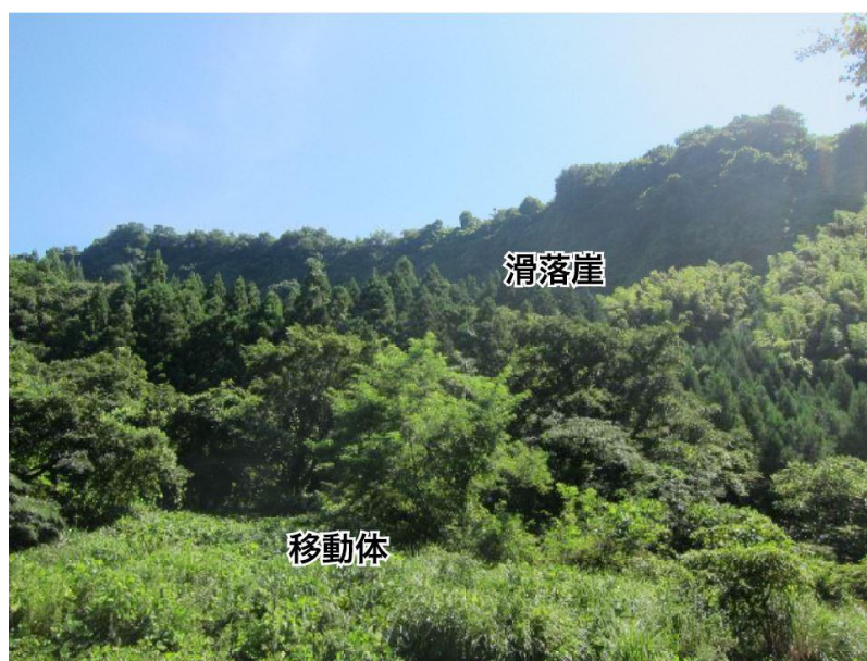
図1 鬼伏地すべりの遠景写真
