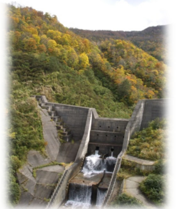
火打山川第一砂防ダム Hiuchi Yamagawa River Control Dam #1
