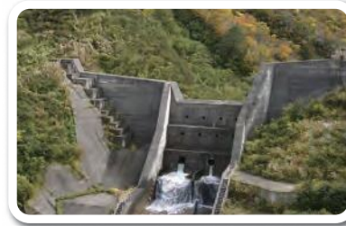
火打山川第1砂防ダム Hiuchiyamagawa River Control Dam #1
