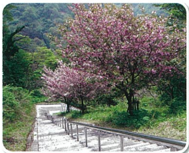
神道山石段 Mt. Shindosan's Stone Steps
